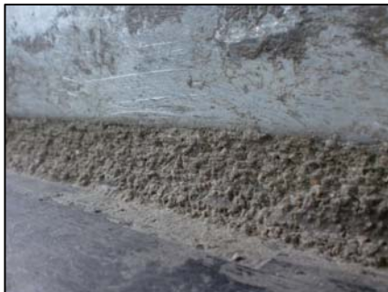
Verfüllung TerraFill-M ... Ansicht von außen
