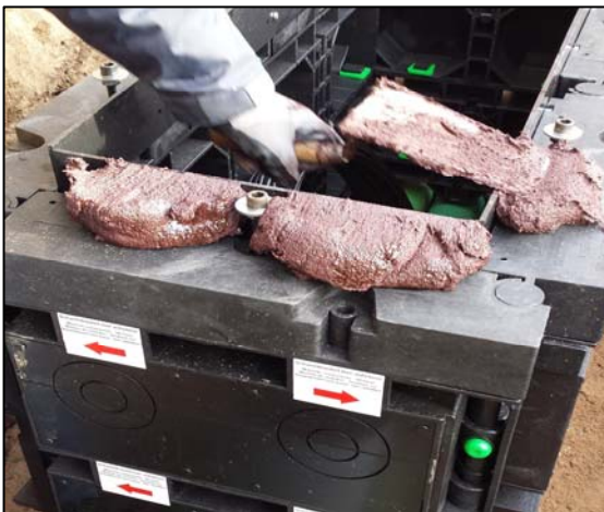
Arbeiten mit Verfüllmasse TerraFill-E
